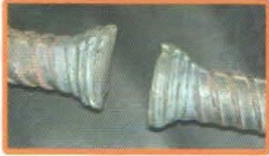
۲- شکست آرماتور جوشکاری شده به روش Gas Pressure Welding پس از رها شدن از دست اپراتور
